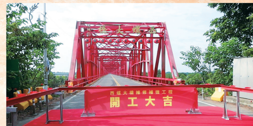
↑ 遠東第一大橋封橋400天施工。
